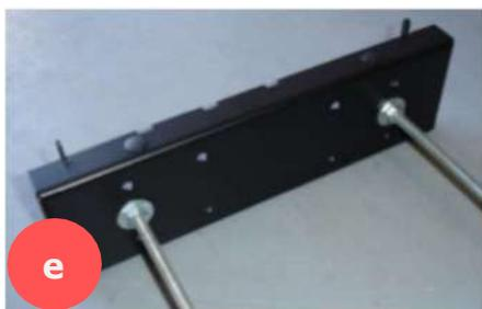
Preparare il sistema nebbiogeno montando le staffe angolari. Tagliare, della lunghezza adeguata, le barre filettate M8 e fissarle alla staffa utilizzando 4 dadi e 4 rondelle da 25 mm.
